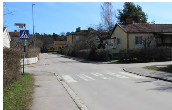
Figur 10. Korsningen Arosg. - Läbyg. Siktproblem bakom häckar och passager över gatorna utan hastighetsdämpande utformning ger bedömningen låg trafiksäkerhetsnivå.
